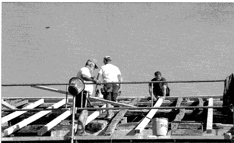
Chantier de transformation d'une grange agricole en habitation. Avec la loi d'avenir pour l'agriculture adoptée en 2015, il n'est plus possible de changer la vocation d'un bâtiment dans les zones agricoles, qu'il y ait cession ou non, sauf en cas d'avis positif de la commission départementale de la préservation des espaces naturels, agricoles et forestiers.
